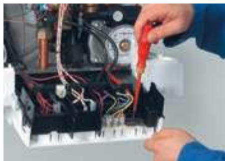
3. Подключение электрических присоединений
