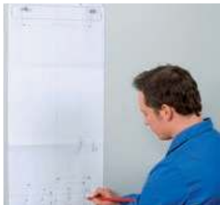
1. Предварительная разметка с помощью монтажного шаблона
