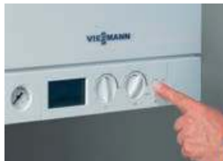
4. Ввод в эксплуатацию
