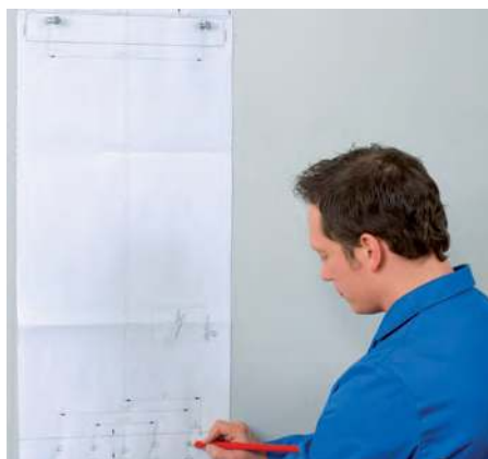
1. Предварительная разметка с помощью монтажного шаблона
