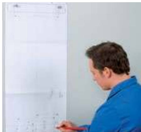
1. Предварительная разметка с помощью монтажного шаблона
