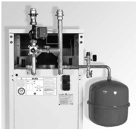
Рис. 4: Собранный гидравлический комплект ACV
