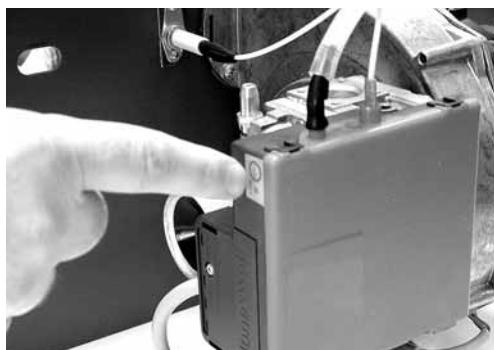
Рис. 25: Кнопка перезапуска горелки
