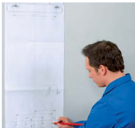
1. Предварительная разметка с помощью монтажного шаблона
