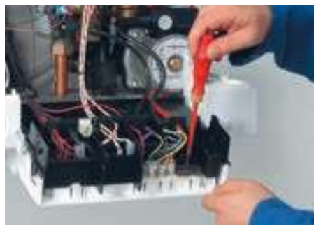
3. Подключение электрических присоединений
