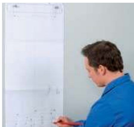
1. Предварительная разметка с помощью монтажного шаблона
