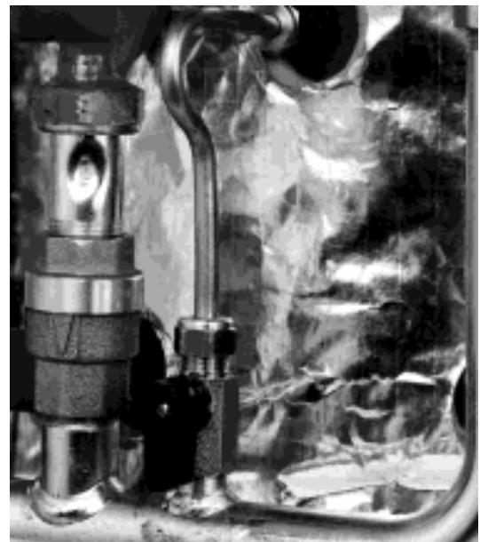
Фото А: Кран заполнения
